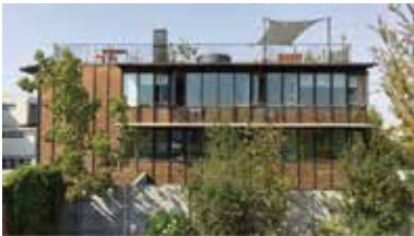
CONJUNTO PEDRO NAVIA Providencia, RM Arquitecto: Cristián Izquierdo L. Edificio de 3 pisos más azotea. Cuenta con 6 dúplex con patio privado y 6 departamentos con azotea privada.
